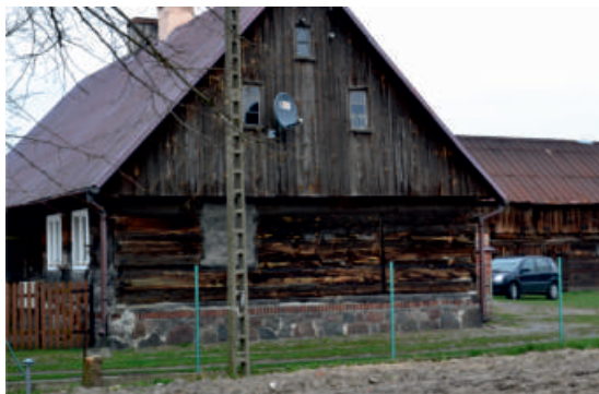
Zagroda olęderska. W budynku inwentarskim widoczny trempel. (fot. A. Funka)
